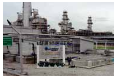
ระบบนำร่อง ณ โรงแยกก๊าซ (อยู่ระหว่างการก่อสร้าง)
